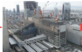
2009. 秋 ビルの鉄骨は完成に近づいており、駅の上ではドームを組み立てるために必要な足場が準備されています。
