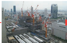
2009. 春 ノースゲートビル西側の低層クティ大阪にはほぼ到達しており、ノースゲートビルの鉄骨も次第に高く組み上がってきています。
