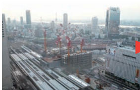
2008. 秋 ビル全体の鉄骨が組み上がってきているとともに、橋上駅（南北連絡橋）部分の鉄骨も姿を現しつつあります。
