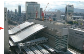
2010. 春 ドームの工事が進み、駅が覆われつつあります。
